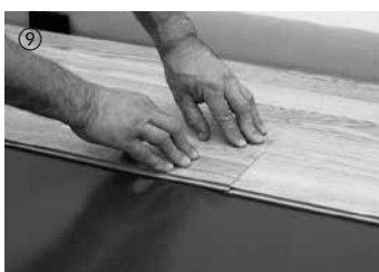
Anschließend wird das Element stirnseitig abgesenkt. Beachten Sie hierbei, dass das Element stirnseitig bündig an das zuvor verlegte Element anstoßt. Durch kurzen Druck auf den Querstoß rastet das Element ein.
